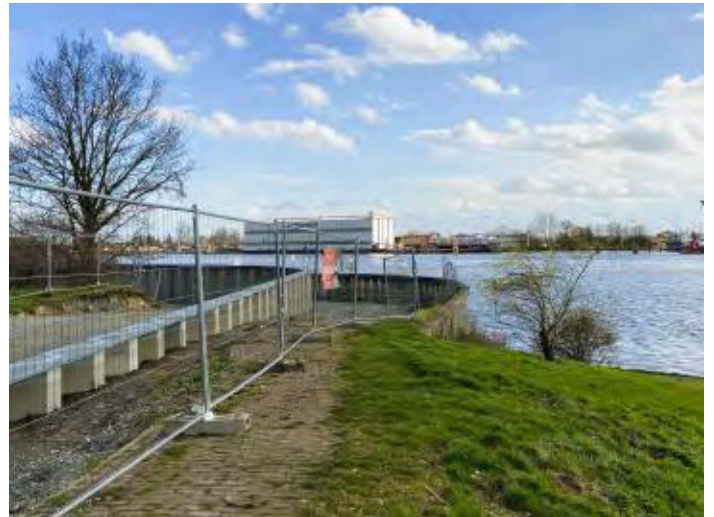
Bild 3: alte und neue Spundwand in Blumenthal
