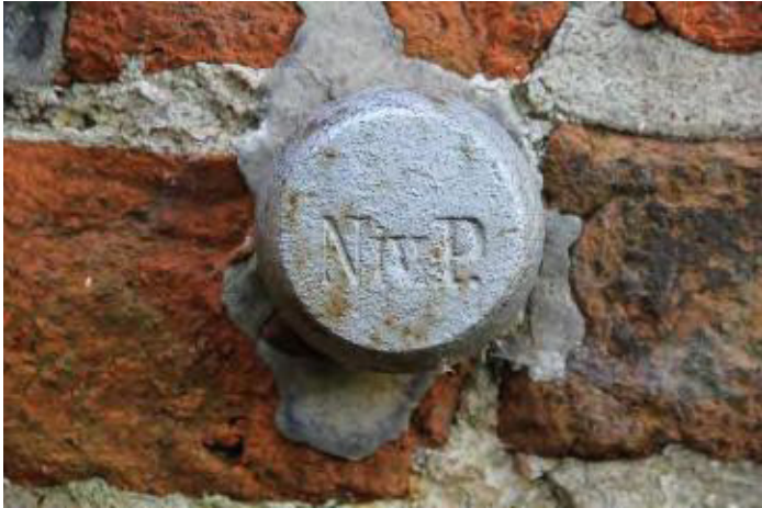
Abb. 6: Mauerbolzen am alten Blumenthaler Kirchturm, dessen Höhe 1890 zu 7,041 m ü. N. N. bestimmt wurde (vgl. Abb. 5). Er trägt lediglich die Inschrift „Niv. P.“, was für Nivellements-Punkt steht. Foto: M. Klemke.
