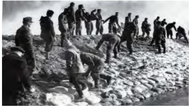
Abbildung 1: Ein gefährdeter Deich wird mit Sandsäcken verstärkt. Abdruck mit freundlicher Genehmigung des Deichverbands am rechten Weserufer
