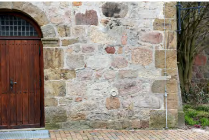
Abb. 4: Lage der Höhenmarke an der Westseite des Kirchturms, ca. 1,5 m neben der Tür in einer Höhe von knapp 80 cm über dem Boden. Foto: M. Klemke.
