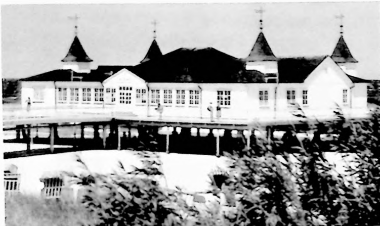
Seebrücke in Ahlbeck
