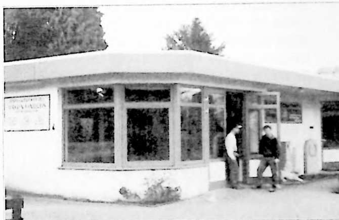
Das Betriebsgebäude an der Ecke Bördestraße / Klostermühlenweg in Lesum
