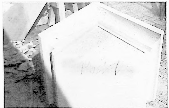
Von Jürgen Hinrichs gefertigter Dreiecksgiebel am Abschlußsims an der Südwestseite des Bremer Doms
