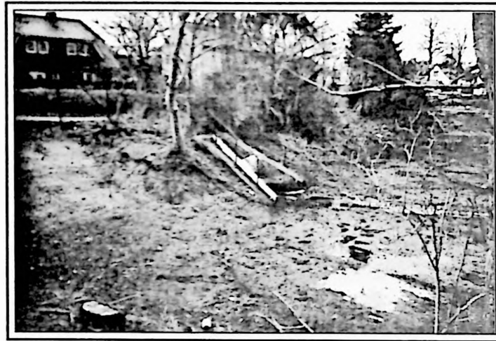
Blick auf den südlichen Teil des gerodeten und vertieften Rückhaltebeckens
