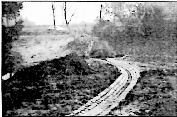
Das Rückhaltebecken während der Sanierungsarbeiten. Man sieht die sanft geschwungene Kurve, in der das scheinbar harmlose Rinnsal des Paschgrabens durch das Becken in Richtung Abfluß läuft.
