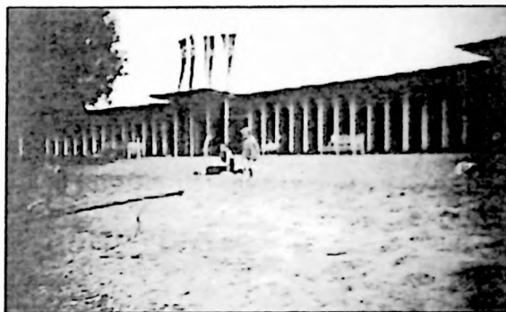
Die dunklen Flächen der Außenwand waren dunkelrot gestrichen.
