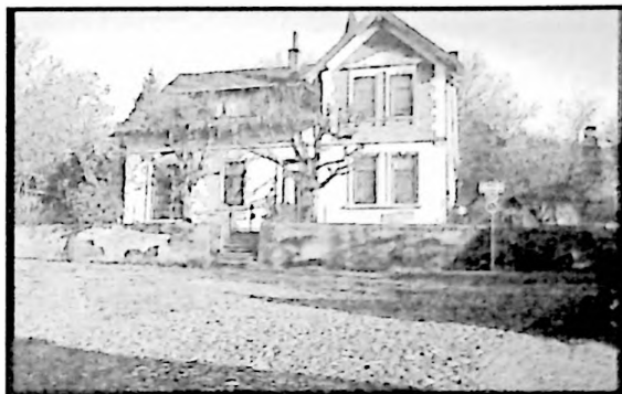
Der alte zum Hauseingang führende Treppenaufgang existiert seit der Sanierung der Straße und der Stützmauer im Jahre 1997 nicht mehr.
