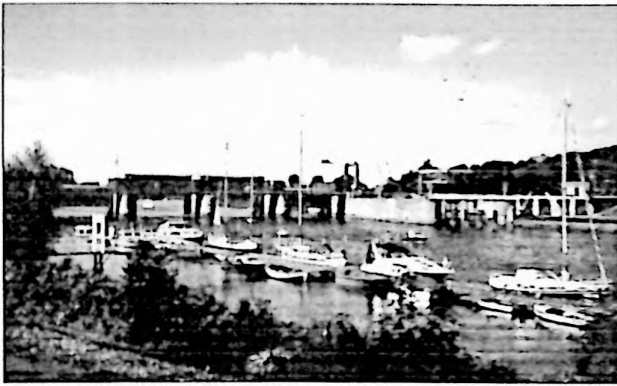
Das Lesumer Sperrwerk wurde im Jahre 1974 fertiggestellt und 1979 in Betrieb genommen.
