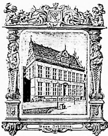
Die älteste existierende Fotografie des Schüttings um 1870 (Archiv der Handelskammer Bremen)
