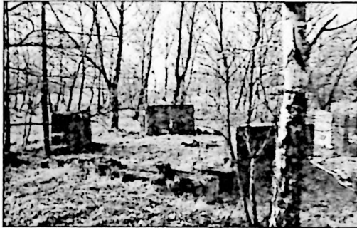
Reste der gesprengten Flakstellung
