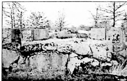
Reste der Flakgebäude
