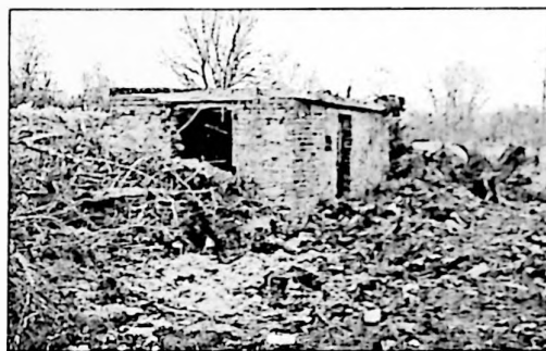
Reste der Flakgebäude
