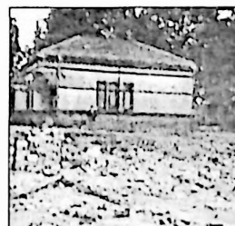
Erhaltenes Bürogebäude der Wollwäscherei nach der Sprengung - 1937
