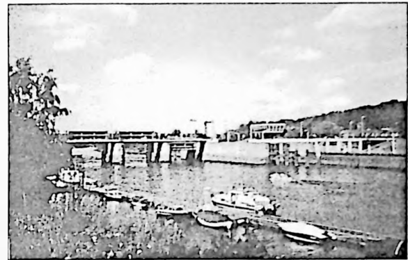
Lesumsperrwerk in Bremen-Grohn
