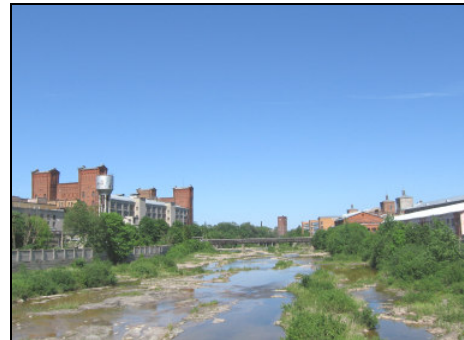
Gebäude der ehemaligen Textil-Manufaktur auf Kreenholm
