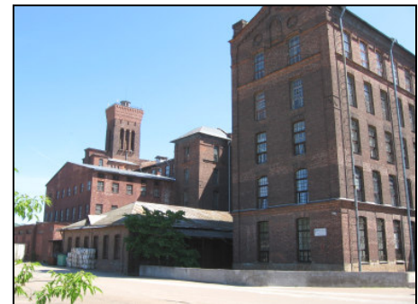
Gebäude der ehemaligen Textil-Manufaktur auf Kreenholm
