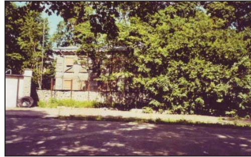
Verdeckt hinter Bäumen befindet sich mit zugenagelten Fenstern das ehemalige Knoopische Wohnhaus
