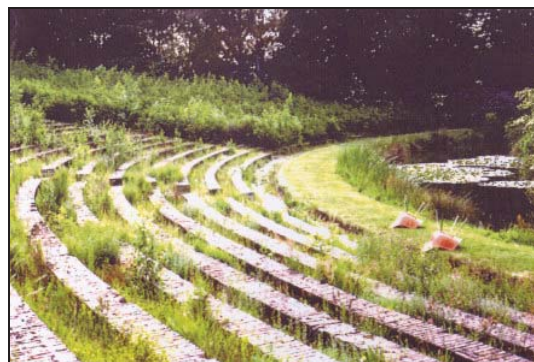
Verwahrloster Zustand der ehemaligen Freilichtbühne in Bookholzberg Foto: R. Matzner
