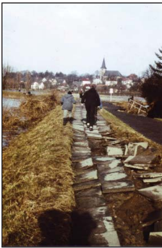
Sichtbare Flutschäden am Lesumdeich nach dem Hochwasser
