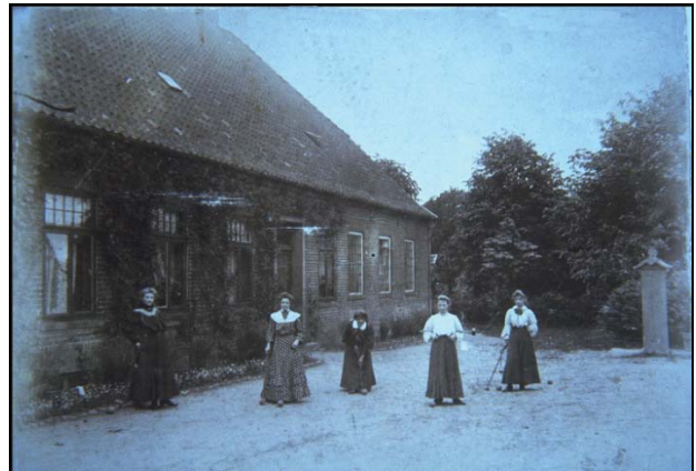
Alte Schule am Alter Schulhof 3 (jetzt Pastorenhaus)
