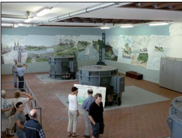
Wandmalereien und Pumpenköpfe in der Pumpenhalle
