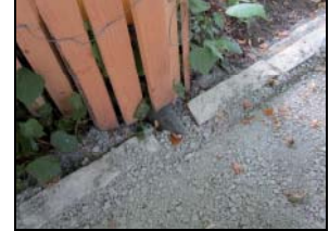
Angebrachte Verkleidung zum Schutz der Bäume während der Baumaßnahme am Wegverlauf zum Haus Schotteck
