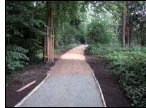
Angebrachte Verkleidung zum Schutz der Bäume während der Baumaßnahme am Wegverlauf zum Haus Schotteck
