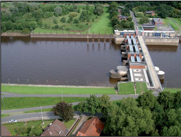
Lesumsperrwerk in Bremen-Grohn - Luftaufnahme
