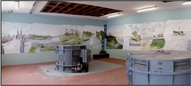
Von Ulf Fiedler angefertigte Wandmalereien in der Pumpenhalle
