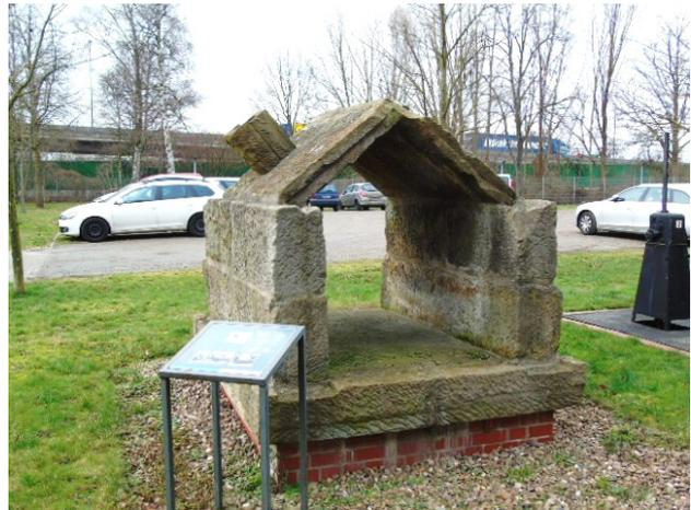
Teilstück der Balge von 1830 mit Sandsteinauskleidung und Überdachung zur Geruchsminimierung
