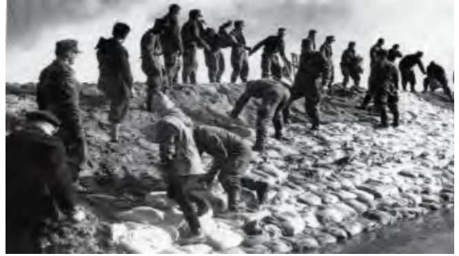
Abbildung 1: Ein gefährdeter Deich wird mit Sandsäcken verstärkt. Abdruck mit freundlicher Genehmigung des Deichverbands am rechten Weserufer
