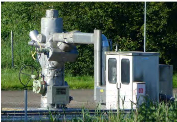
Abb. 3 Kavernenkopf L203 (Foto: N. Kück)
