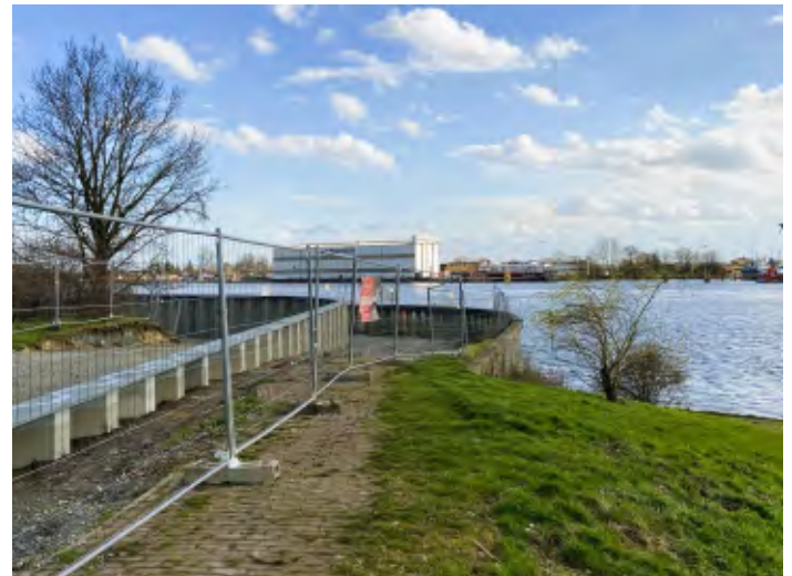
Bild 3: alte und neue Spundwand in Blumenthal
