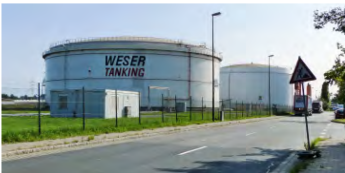
Abb. 8 Großtanks für Mineralöl an der Hüttenstraße (C) (Foto: N. Kück)
