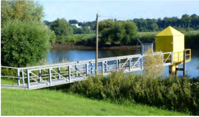
Abb. 6 Frischwasser-Entnahmestelle (A) (Foto: N. Kück)
