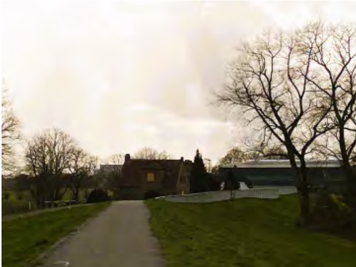
Bild 2: Ende der Spundwanderhöhung
