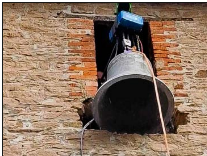
Die Glocke hält Einzug in ihr künftiges Zuhause. Der Ausbruch an der südlichen Schallluke ist inzwischen wieder verschlossen.
