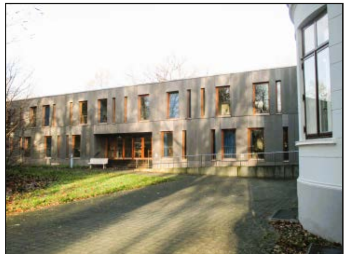
Erweiterungsbau Adelenstift, HVL-Archiv-Nr. F07505
