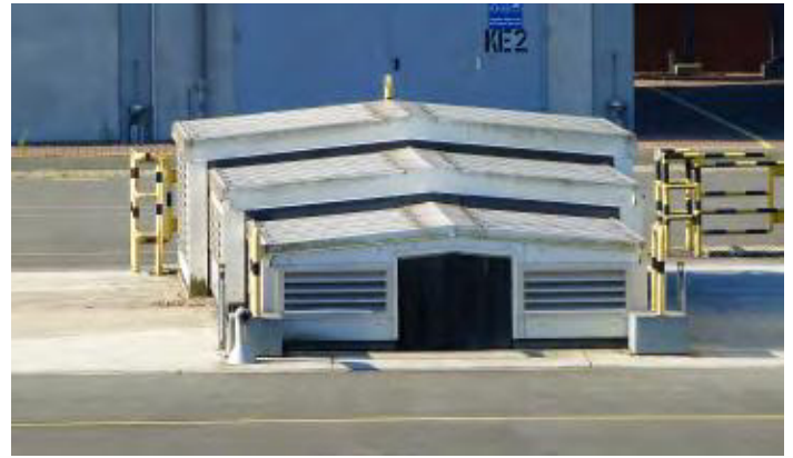
Abb. 4 Verschiebbare Einhausung für die Kavernenköpfe L301 und L302 (Foto: N. Kück)
