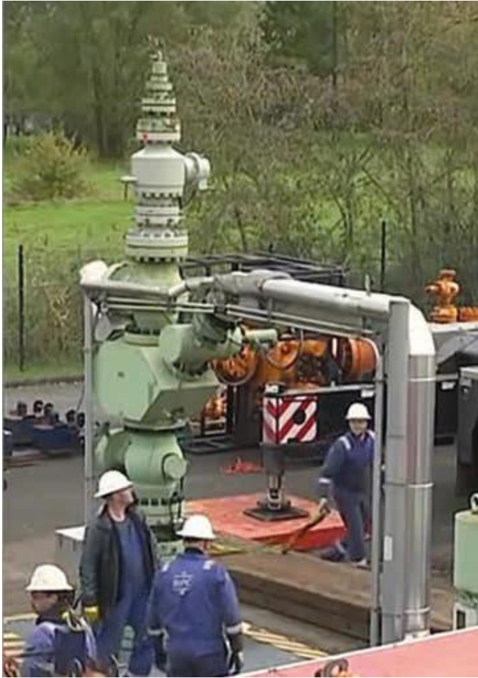
Gaskaverne L201, Vorbereitung der Flutung; die Arbeiter zeigen die Dimension der Anlage (Auszug aus Video buten un binnen, siehe Quellen)
