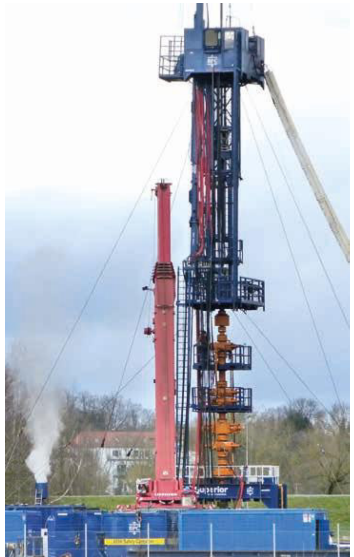
Snubbing-Unit, hier bei der Vorbereitung der Flutung von L203. Der blaue Container verdeckt den Kavernenkopf. Links der Ausbläser mit Dampfvolke. (Foto: N.Kück, März 2021)
