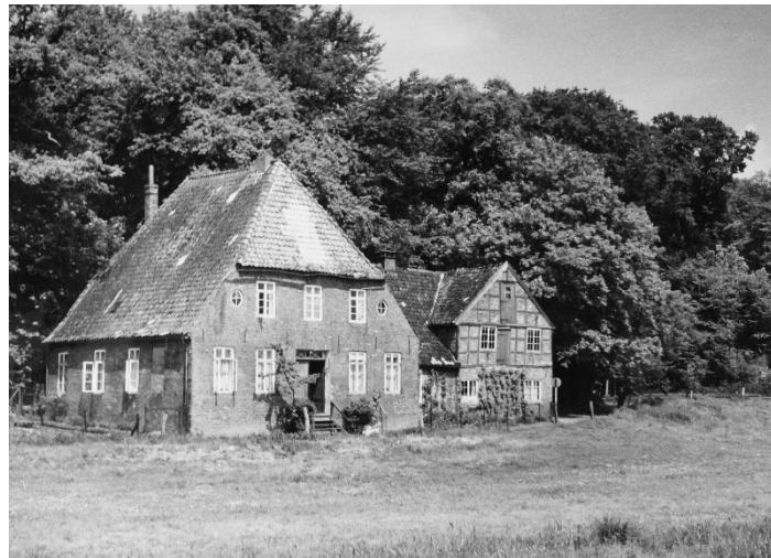
Gebäude der ehemaligen Raschens Schiffswerft in St. Magnus 1930 (HVL-Archiv F00287)
